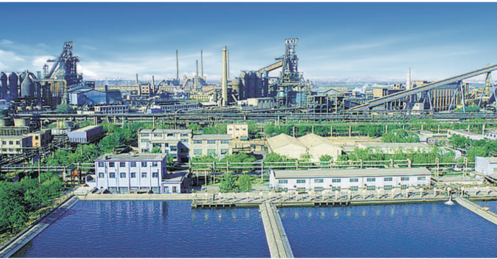
唐钢扩建一期工程1号高炉——鲁班奖
