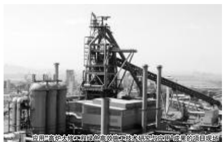
应用“高炉大修工程绿色高效施工技术研究与应用”成果的项目现场
