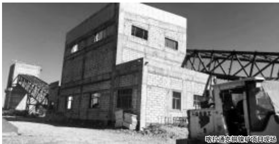
喀拉通克铜镍矿项目现场
