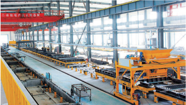
预制构件生产车间
